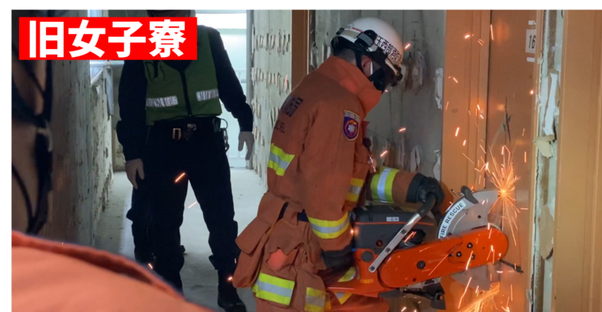
解体中の旧女子寮を使用し、飯能日高消防署が救助訓練のため扉を切断しています。
